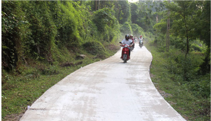
Đường nội thôn Tổng Cổ, xã Yên Đĩnh, huyện Chợ Mới, tỉnh Bắc Kạn vừa được bê tông hóa khang trang, tạo thuận lợi cho nhân dân thông thương hàng hóa.
