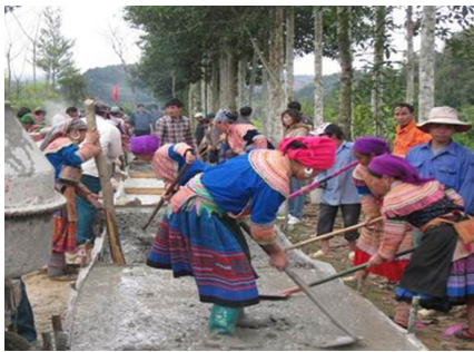
Đồng bào các dân tộc thiểu số thôn Nậm Kha 2, xã Nậm Lức- Bắc Hà tích cực đóng góp công sức, tiền của, hiến đất để đổ bê tông đường giao thông nông thôn, chung sức xây dựng nông thôn mới.
