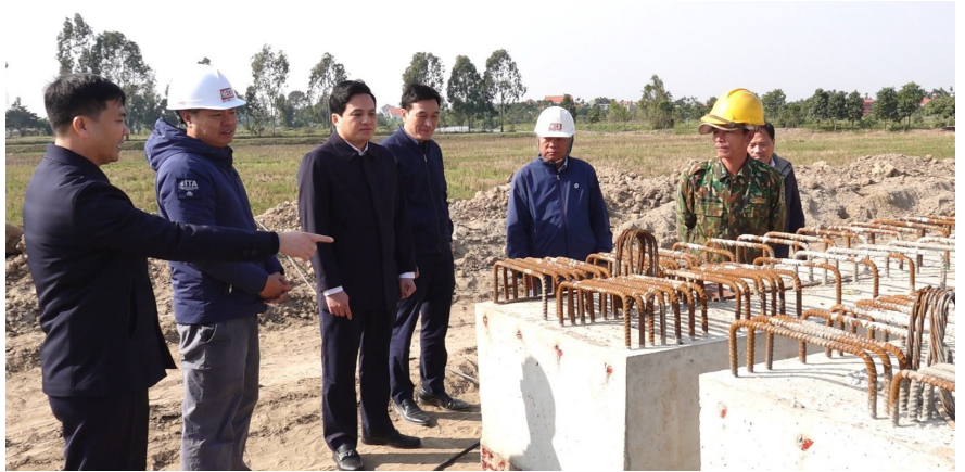
Ông Lê Anh Dũng, TUV, Bí thư Huyện ủy, Chủ tịch HĐND huyện Kim Thành, cùng đ/c Nguyễn Ngọc Tuyến – Phó Bí thư thường trực Huyện ủy đã đi kiểm tra tiến độ thực hiện xây dựng các công trình trọng điểm tại huyện.
