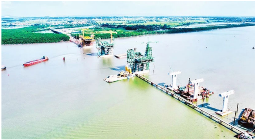
Công trình cầu Bến Rừng có vốn đầu tư gần 2 nghìn tỷ đồng nối huyện Thủy Nguyên (Hải Phòng) với thị xã Quảng Yên (tỉnh Quảng Ninh) đang được đẩy nhanh tiến độ để hoàn thành trong năm 2024.
