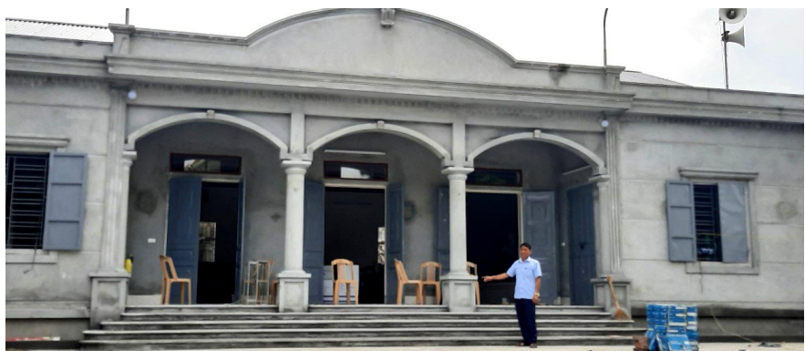
Nhà văn hoá thôn Cát Vinh đang hoàn thiện đưa vào sử dụng
