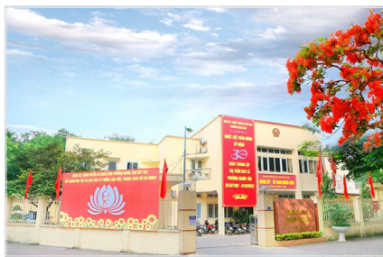
Trụ sở Đảng ủy, UBND phường Nghĩa Tân
