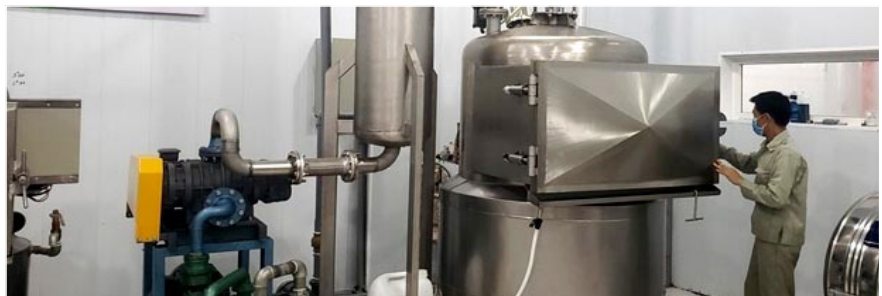
Hệ thống máy sấy trái cây của Công ty Apanax - Đề án được kinh phí khuyến công tỉnh hỗ trợ
