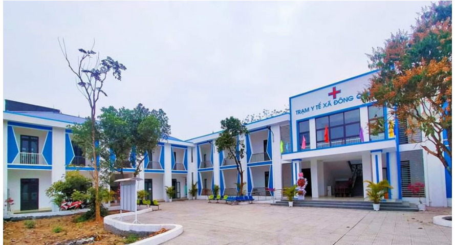
Trạm Y tế xã Đông Quang mới xây dựng.
