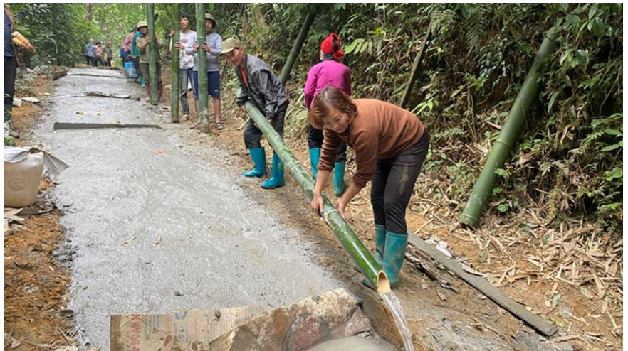
Người dân dùng thân cây vầu đựng nước để vận chuyển đến các vị trí thi công.
